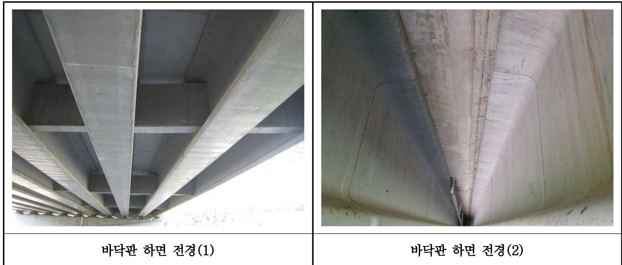
【사진 25.3.2】 바닥판하면 전경
