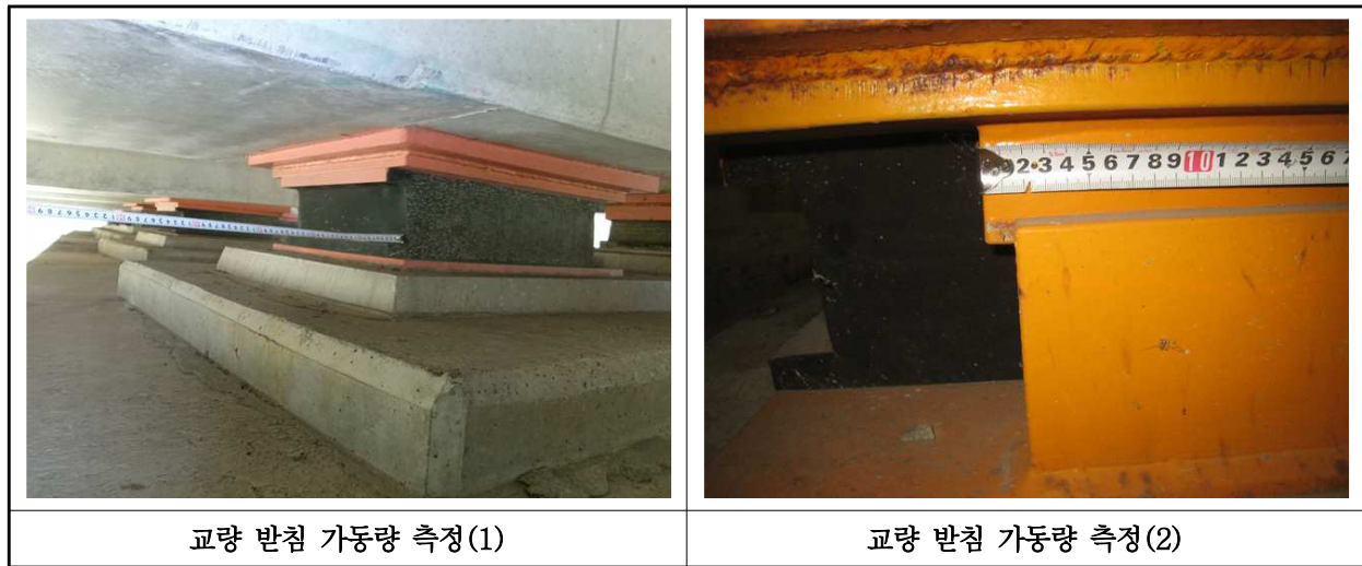
【사진 25.3.15】 교량받침 이동량 측정
