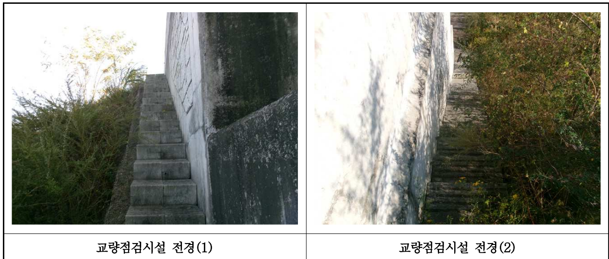
【사진 25.3.25】 교량 점검시설 전경
