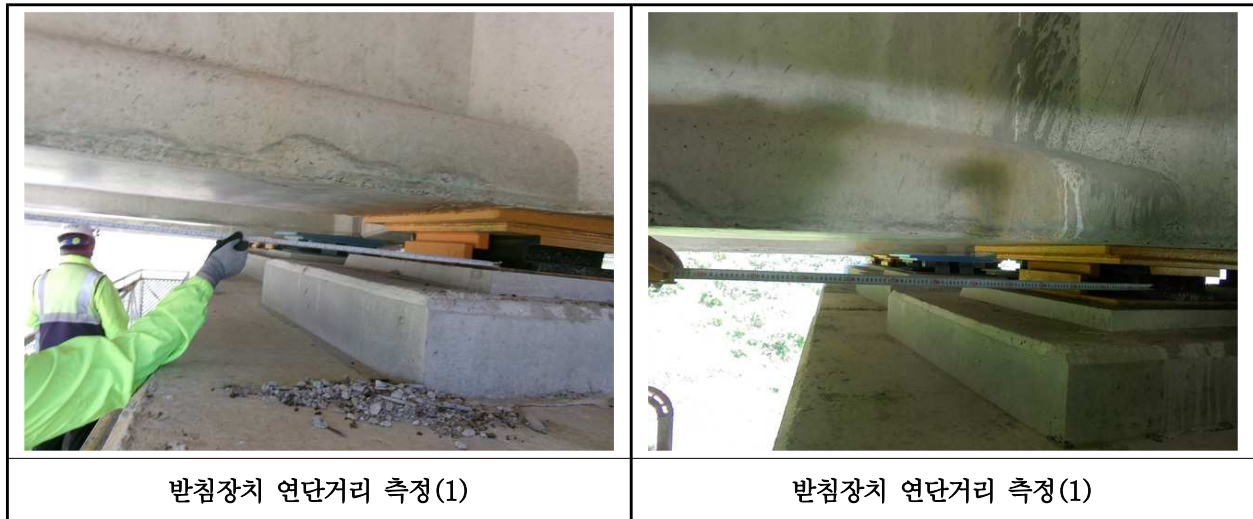
【사진 25.3.14】 교량받침장치 연단거리측정
